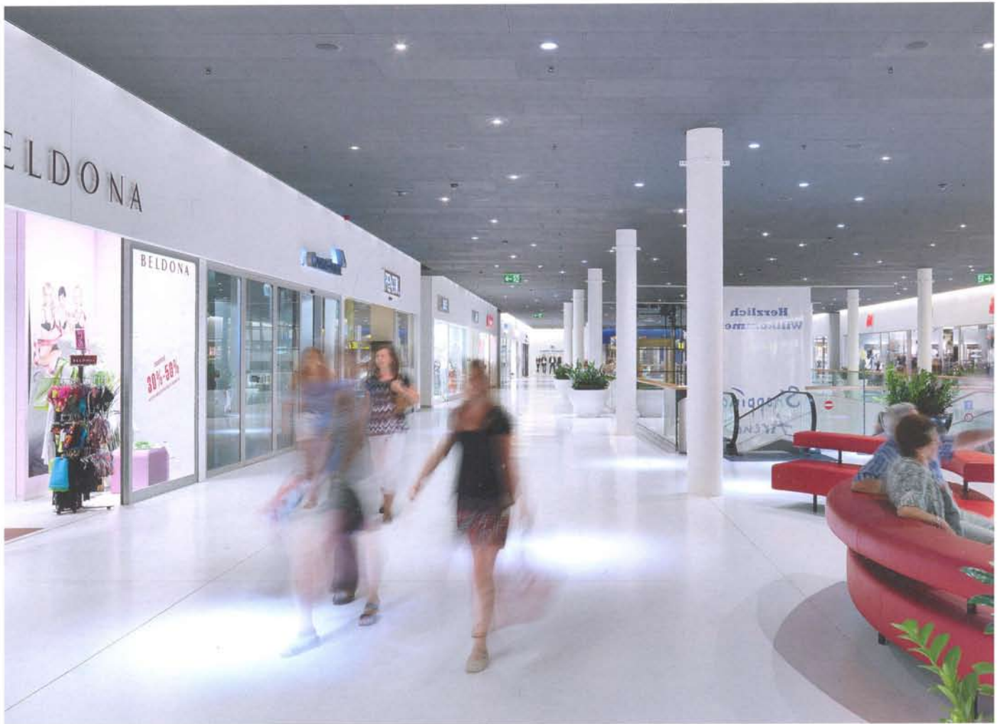
„Künstliche Sonnen“ bündeln das Licht und erzeugen dekorative Lichtinseln auf den Fußböden der Shopping Arena (Bild oben). Die Reflektoren der Lochstrahlerreihe werden ohne Werkzeug in einheitliche Deckenaussparungen montiert (Detailschnitt und Untersicht im Maßstab 1:5).
