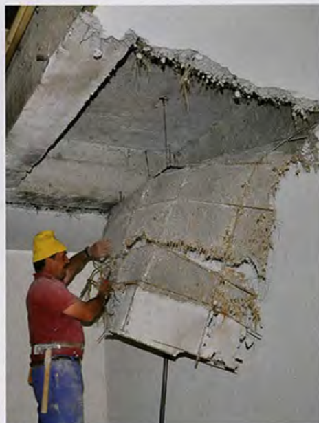
Beim Abbruch war Vorsicht geboten wegen zum Teil schadstoffbelasteter Materialien.
