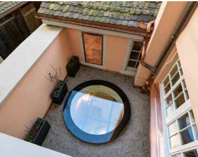
Lichtspender: Das «Dachauge» bringt viel Licht in den hinteren Bereich des Ladengeschosses.
